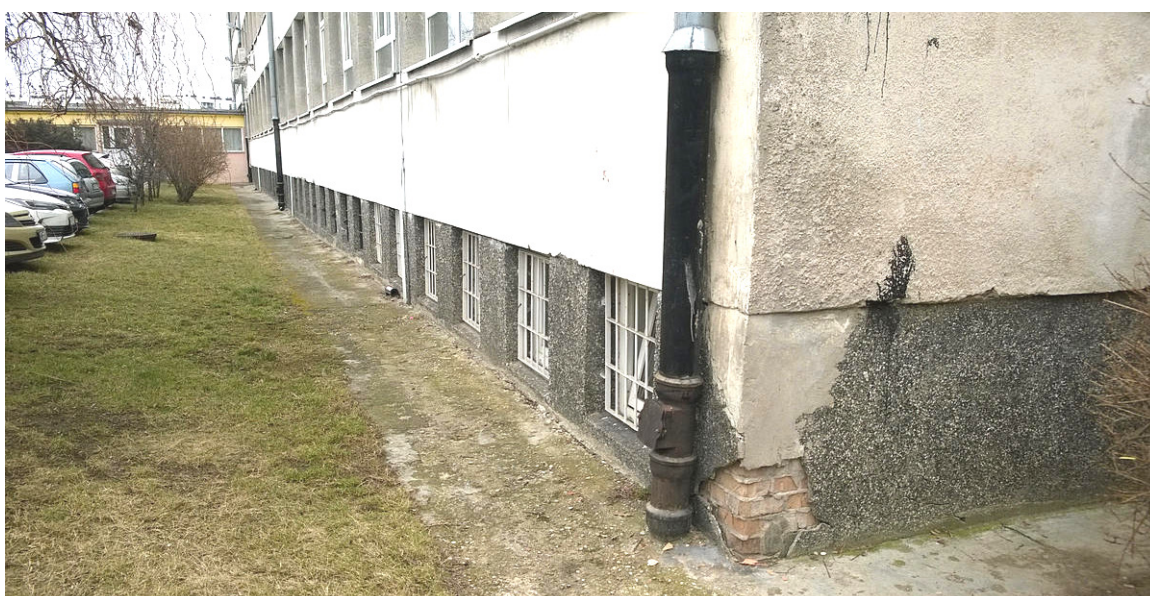
Uszkodzenia okładziny lastryko cokołu budynku głównego.
