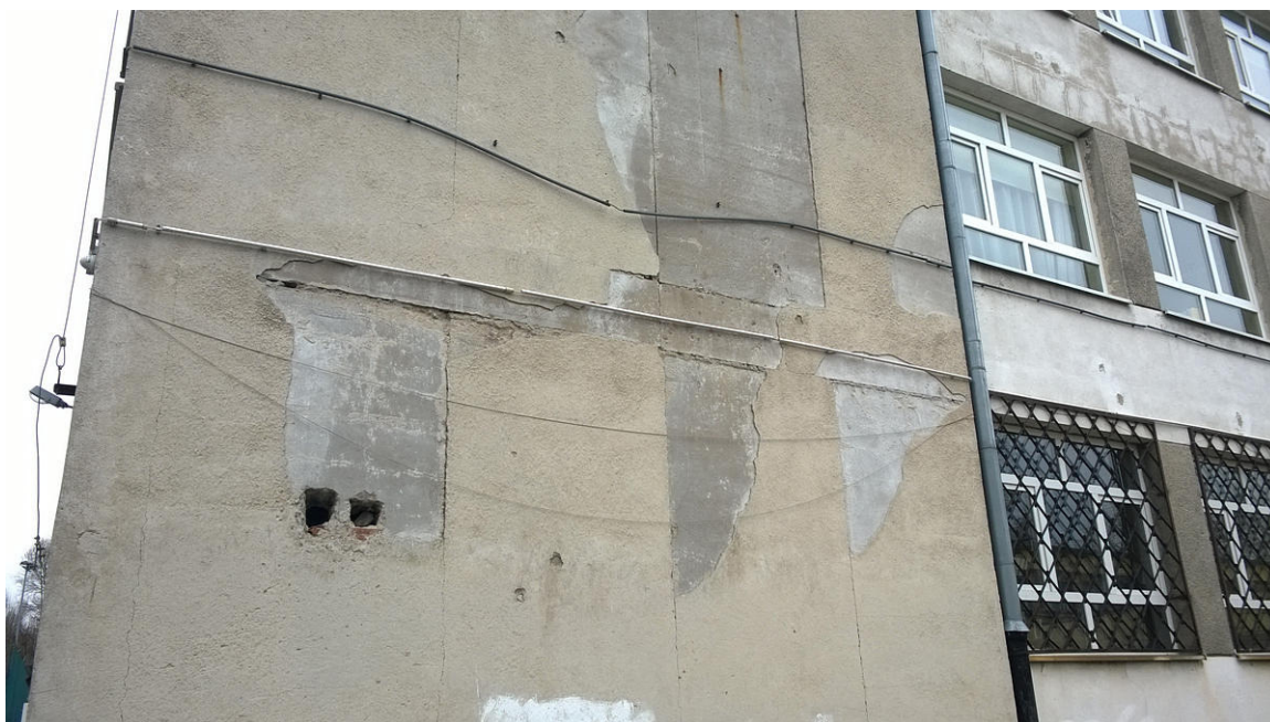
Odparzone tynki na elewacji pld. budynku głównego.
