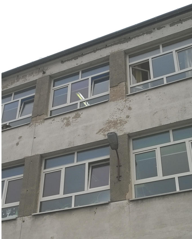
Uszkodzenia tynku na elewacji południowej.
