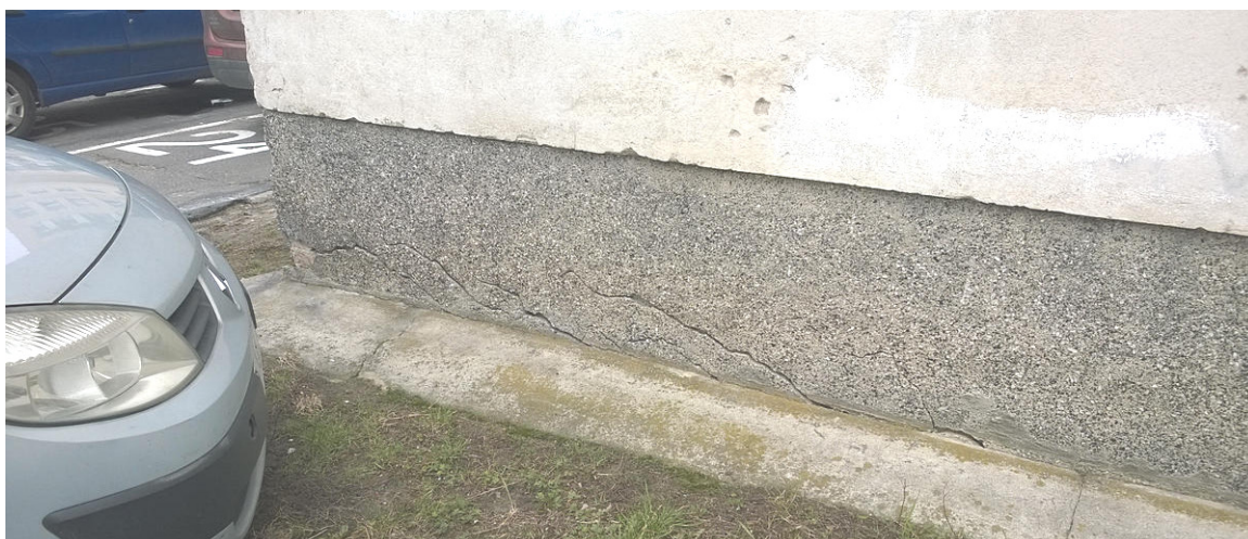
Odparzone tynki na elewacji pld. budynku głównego.
