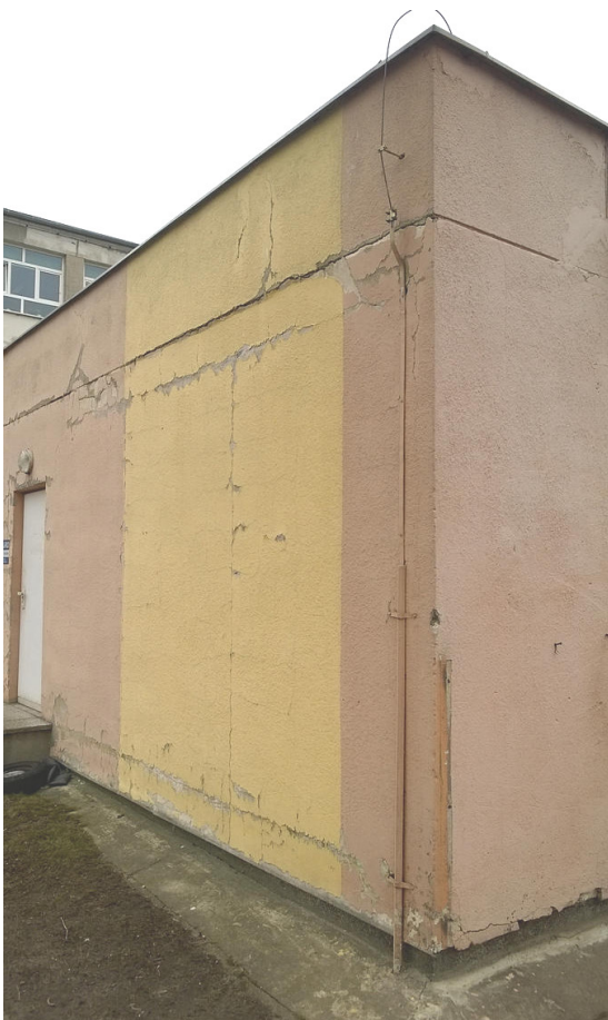
Spękania ścian zaplecza i sali gimnastycznej.
